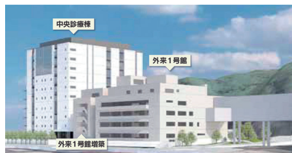
北側道路より計画建物を見る
